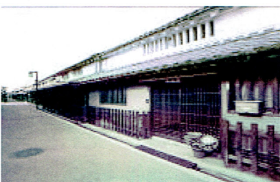
▲ 電線類の地中化(整備後) 中町筋
