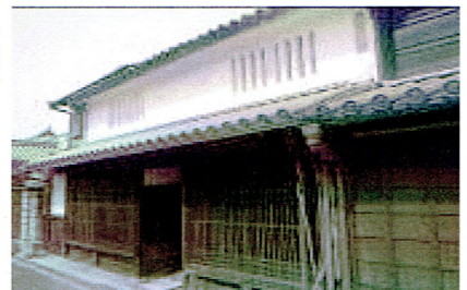
▲ 修理後の伝統的建造物
