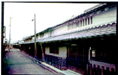
▲ 電線類の地中化(整備前) 中町筋
