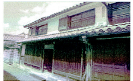
▲ 修理前の伝統的建造物
