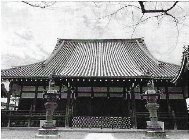
修復工事が完了した 稱念寺本堂
